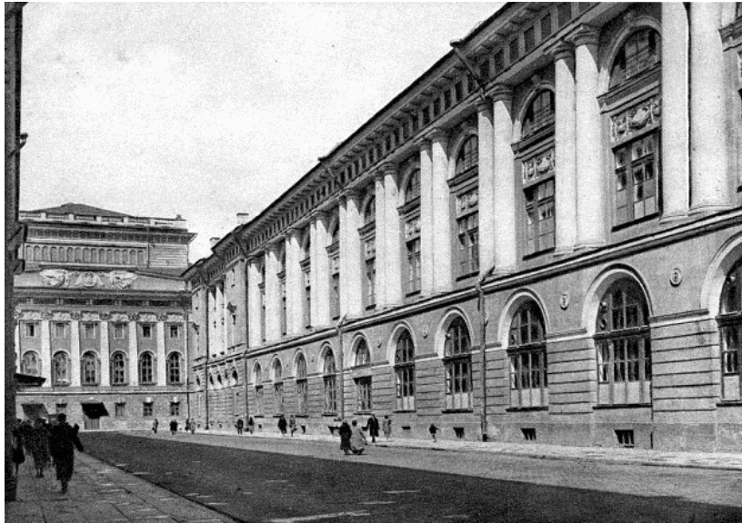
Здание балетной школы на ул. Зодчего Росси (ныне Академия танца им. А.Я.Вагановой)
