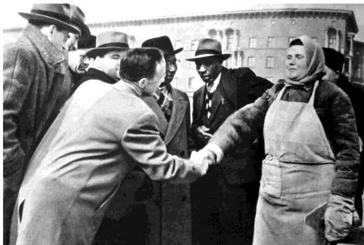
Стройка жилого дома на Можайском шоссе
